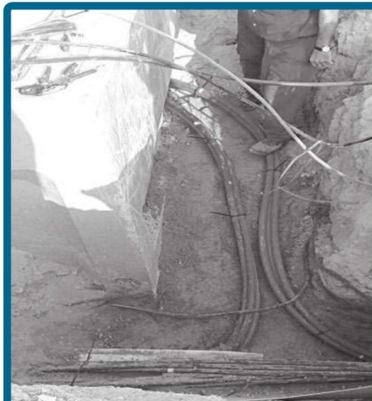
Instalación subterránea de cables.
