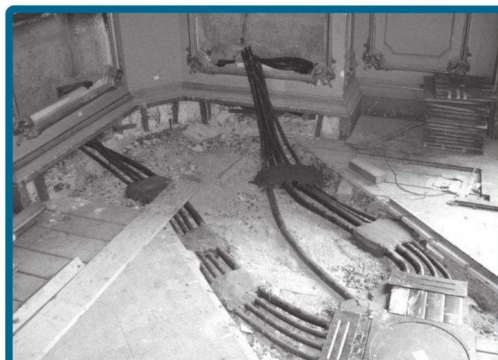
Punto de enlace entre un piso ducto y las instalaciones embutidas en las paredes.
