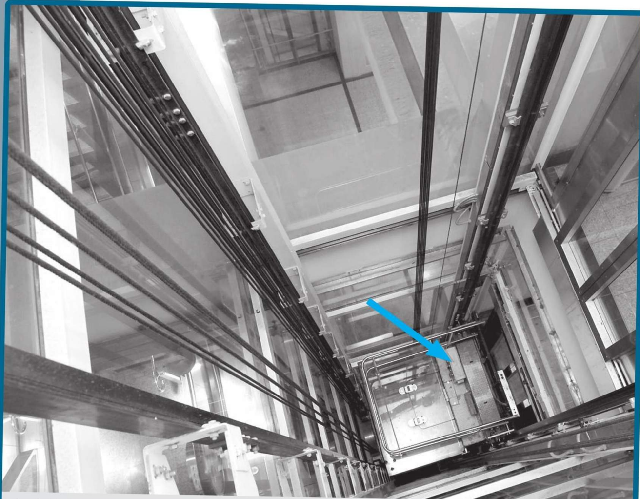
Instalación de ascensores. Cabina vista desde arriba. Obsérvese el tablero de comando localizado sobre ella, indicado con una flecha azul.
