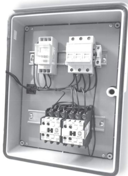
Aquí vemos un tablero de comando y protección de un motor trifásico.
