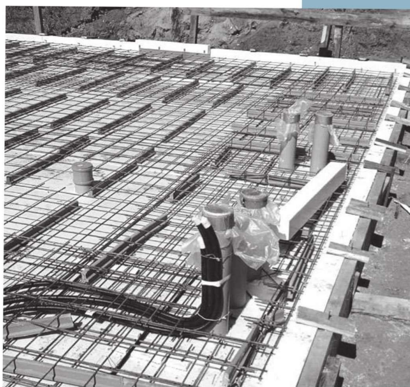
Realización de instalaciones debajo de un piso.
