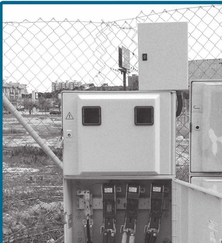
Típico conexionado en un buzón de distribución donde vemos cómo se deriva hacia una línea de alimentación.
